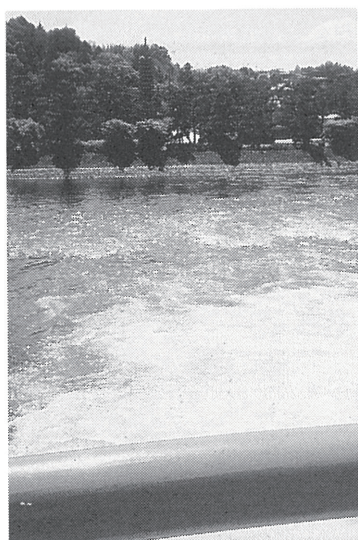
大正初めから稼働して今も現役の宇治発電所。その放流水が宇治川へ注ぐ。
