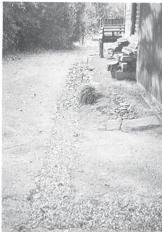
興隆寺釈迦堂（中興堂） 周囲の排水工事始まる。
