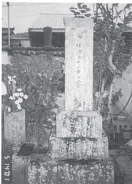
笠山の石で造られている。外玉垣 が失われて、左に傾き、敷石が壊 れた状態である。大正時代の写真 にはアーチ状の門柱もあった。
