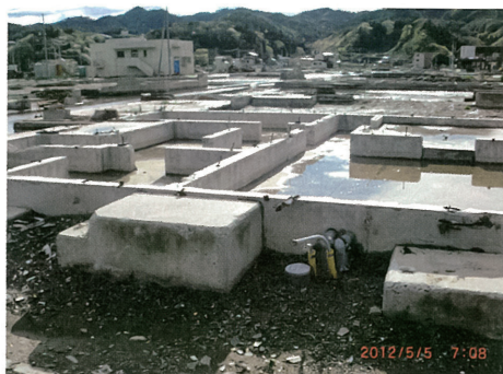
④③平成24年5月5日 建物全てが大津波によって流れ家 家の土台だけが残った状況（気仙沼市鹿折地区）
