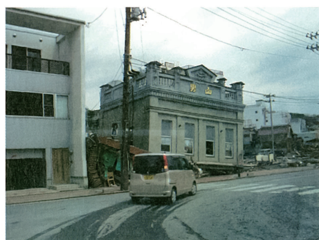
㉜地震と津波で倒壊した古い酒屋さん「男山」 (5月3日)
