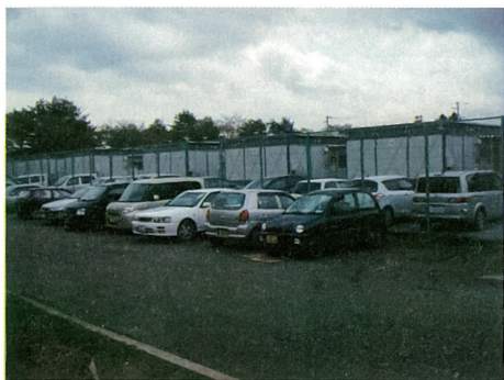
⑤②気仙沼市立小学校下に仮設住宅が建設中だった
