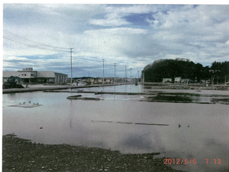
④④平成24年5月5日 前日の大雨の雨水がまだ排水でき ていない様子（気仙沼市鹿折地区）
