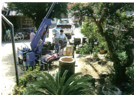
老朽荒廃墓碑解体工事開始伊勢島修工務店 右のサルスベリは伊藤公お手植え
